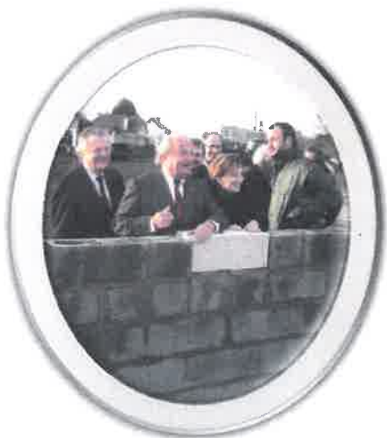
8 JANVIER 2014 : POSE DE LA PREMIERE PIERRE RESIDENCE SENIORS
