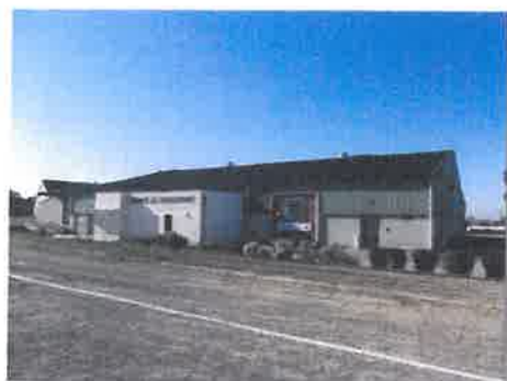
CONSTRUCTION D'UN SAS A L'E.L.C.
